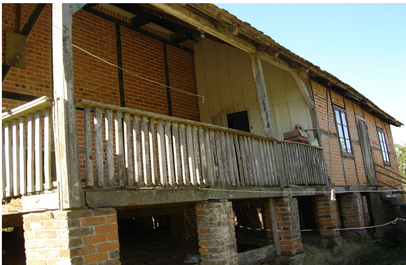
FOTO DA FACHADA DOS FUNDOS
