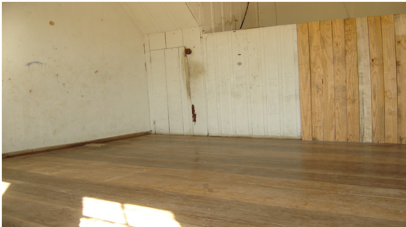
FOTO DAS DIVISÓRIAS FEITAS SOBRE O PISO EXISTENTE
